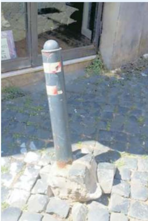
▲ Il piloncino estraibile Piloncino in ferro abbattuto per permettere un parcheggio e poi rimontato assai precariamente su una buca
