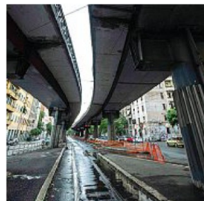
Il tratto di Tangenziale est che verrà abbattuto (LaPresse)
